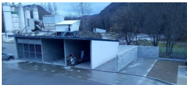
Déchèterie d'ARIGNAC – Local de déchets dangereux
