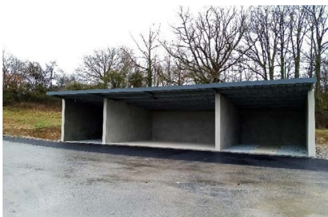
Déchèterie de LEZAT sur LEZE – Travaux en cours
