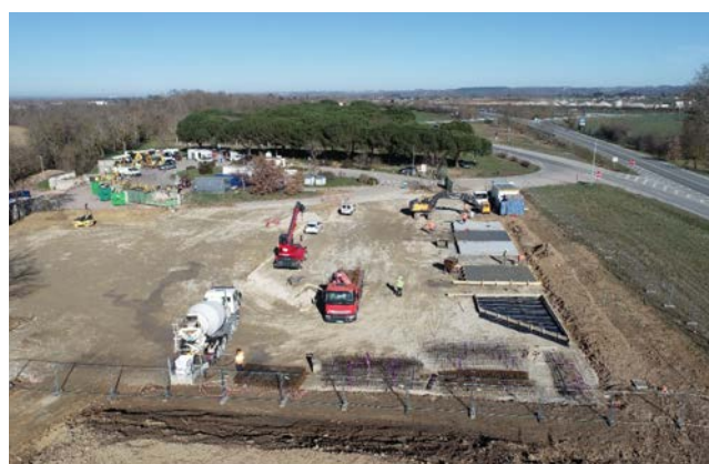
Déchèterie de SAVERDUN – Travaux en cours
