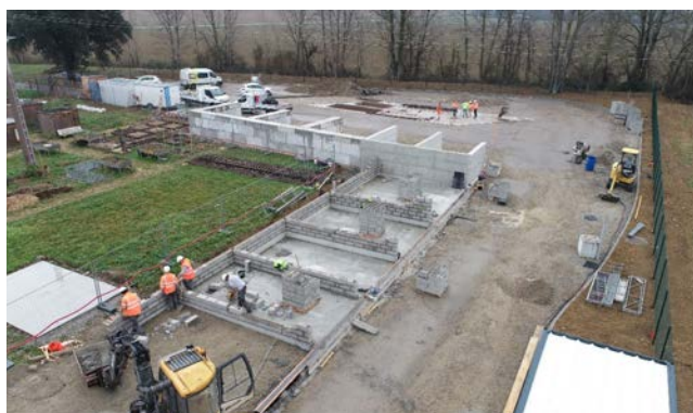
Déchèterie de LES BORDES sur ARIZE – Travaux en cours
